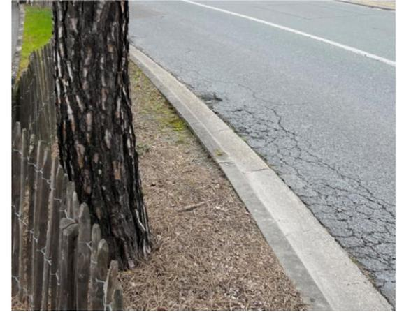
Les racines des pins engendrent des déformations qui causent des problèmes de sécurité sur la chaussée.
